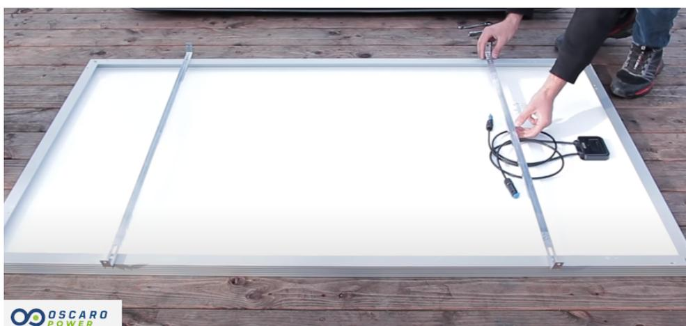
3. Déposer l'assemblage panneau solaire et barres métalliques sur le bac plastique. Sortir les câbles du panneau vers l'extérieur du bac. Centrer le panneau en hauteur et largeur en veillant à ce que le matériau du lestage ne dépasse pas et par conséquent ne gêne pas l'installation.
